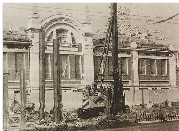
Вбивание первых свай станции пл. Ленина 1981 г.
